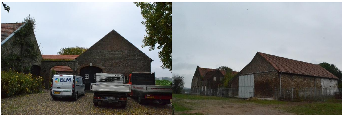
Figuur 1.4 Links de bedrijfswoning Wienerte en rechts de te renoveren hoeve Wienerte.
